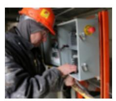
A TECHNICIAN WIRES THE PANEL TO CONTROL THE ROLL GEN SYSTEM.
